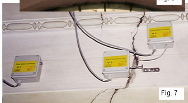
Fig. 6- 7 Applicazione di sensori
